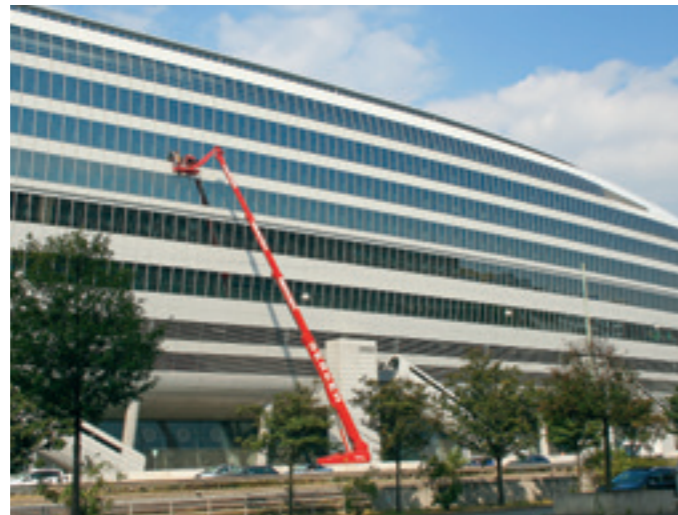
▲ Ein Fall für die 57 Meter hohe GT 570-25 AkLPG: Das markante Gebäude „The Squire“ am Frankfurter Flughafen ist 45 Meter hoch und hat eine Glasfläche von rund 600 Metern Länge.
